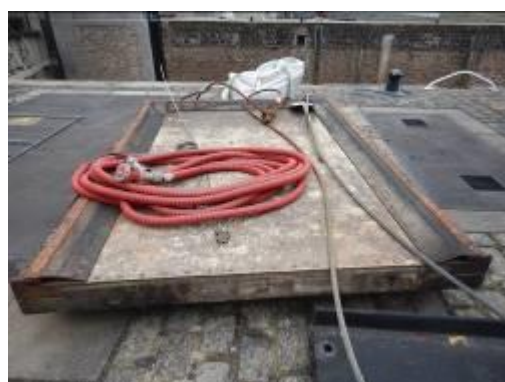
Provizorní hrazení dolního ohlaví MPK
