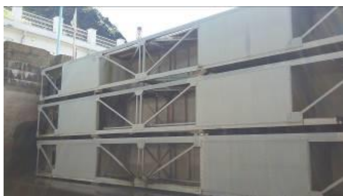
Provizorní hrazení horního ohlaví MPK
