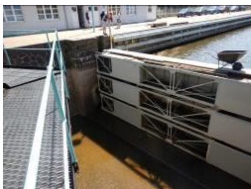
Provizorní hrazení horního ohlaví MPK
