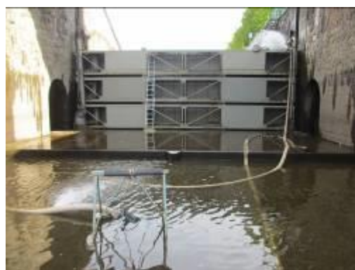
Provizorní hrazení horního ohlaví MPK
